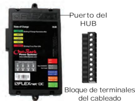
1. Monte el cableado del FN-DC tal y como se muestra en el manual para el FN-DC.
