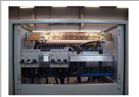
Eine Standard-Verteilereinheit mit AC-Ausgang hat eine 35 mm Hutschiene, Multi Clip Anschlüsse, N/PE Klemmleisten aus Kupfer und gehört zum Schaltschrank.
