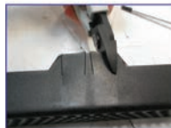
Aussparungen für Kabeleintritt ausschneiden
